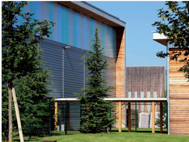
Changement de matériaux aux décrochements volumétriques
