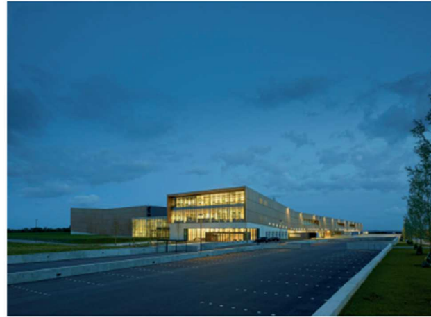
Eclairage limité dans les zones circulées
