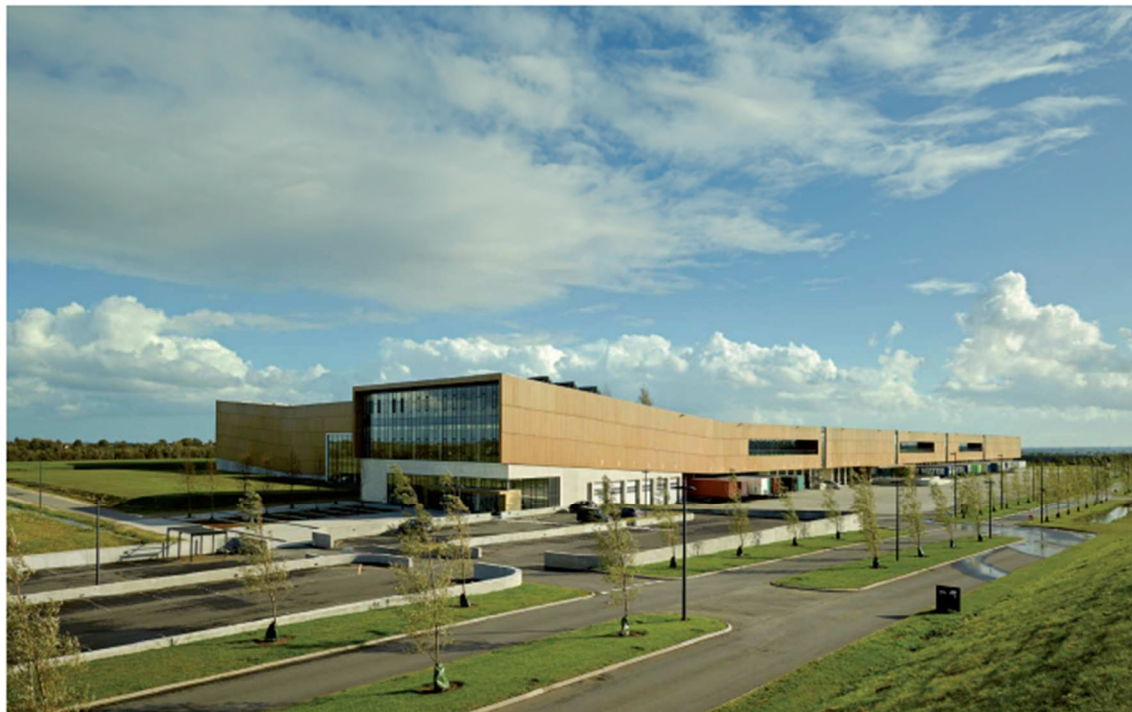
Façades et matière
