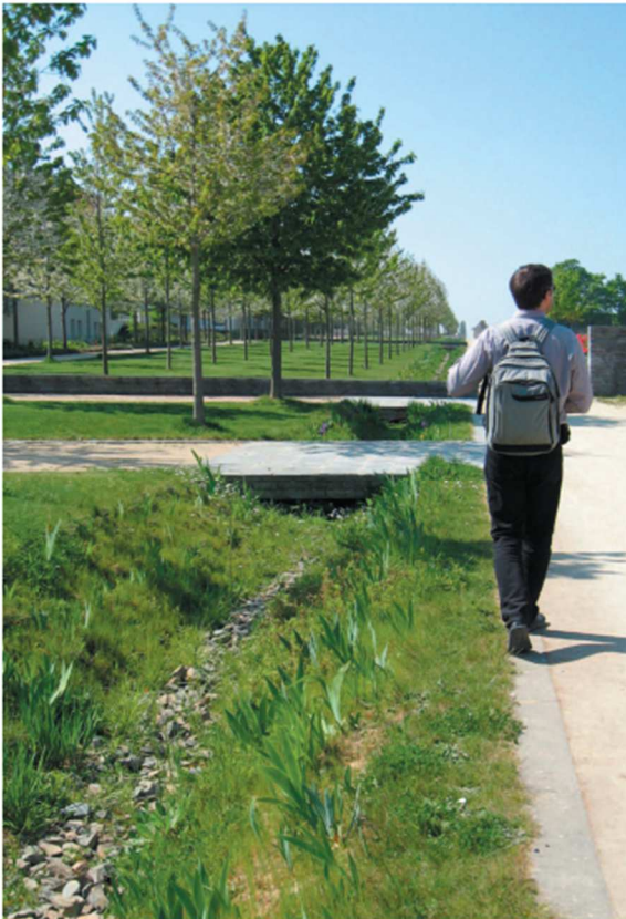
noue et ponceau
